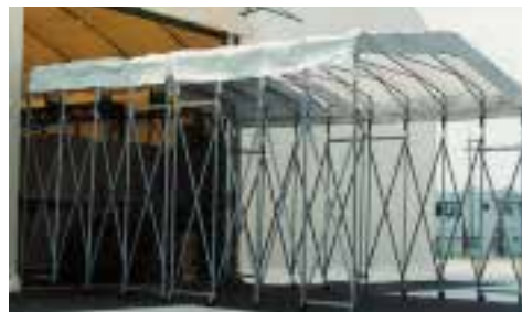
建物間の仮設通路/物流倉庫
